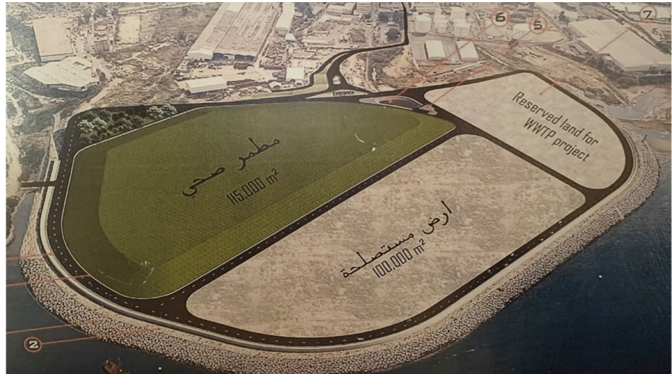
Figure 2 : Vue des trois secteurs de la décharge
